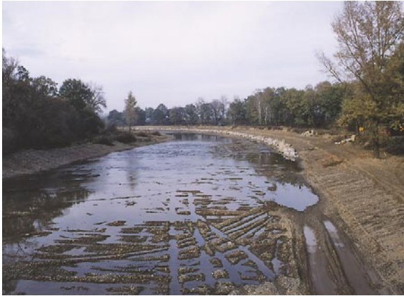
Regulacje średnich rzek polegają zazwyczaj na zawężaniu i ujednoliceniu ich koryta oraz zabudowie brzegów kamieniem.
