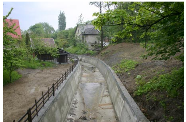
Betonowanie potoków i prostowanie rzek kapitalnie zwiększa ryzyko powodziowe szczególnie na odcinkach niżej położonych. Fot. TnZ/Robert Wawręty
