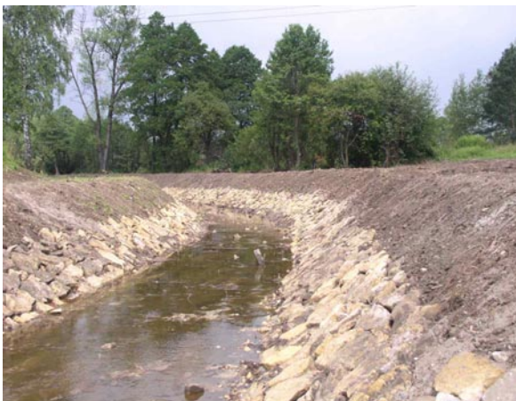
W wyniku regulacji potok Chechło zamieniono w trapezowy kanał, niszcząc przy okazji ok. 50% areалу zajmowanego przez łęgi i olsy.
