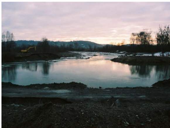
Prace regulacyjne nad Stradomką w 2002 roku.
