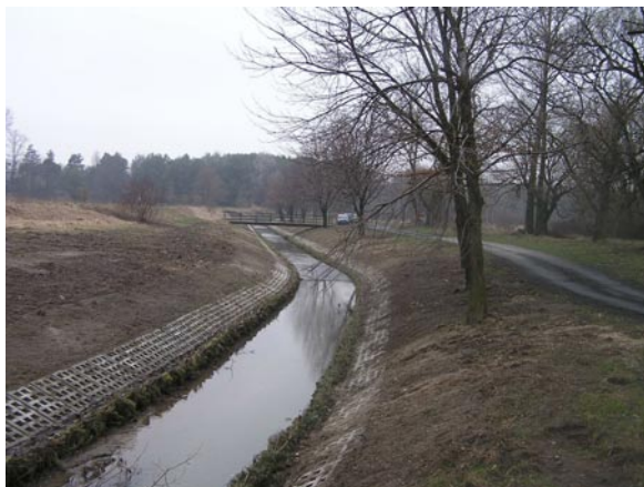
W świetle przepisów prawnych regulacja Krztyni była budową, a nie remontem.
